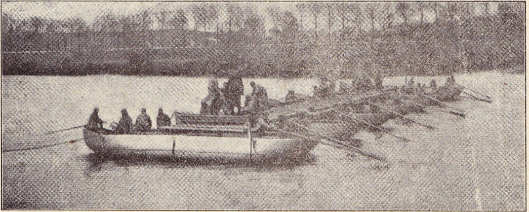
Het aanleggen eener noodbrug.
